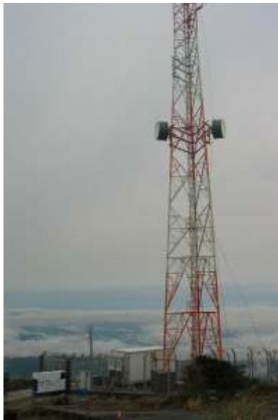
Site de Telecom a 1.500m de altitude (PR)
